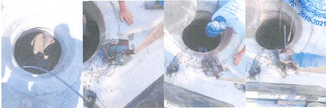
Desazolve de drenaje en calle amarillas en el mes de octubre.
