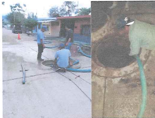
Desazolve de drenaje en línea principal en calle amarillas.
