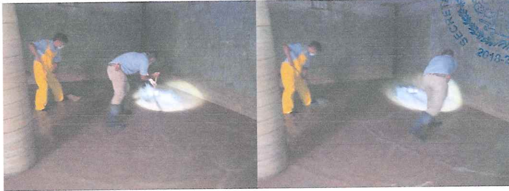
Limpieza del depósito del polvorín
