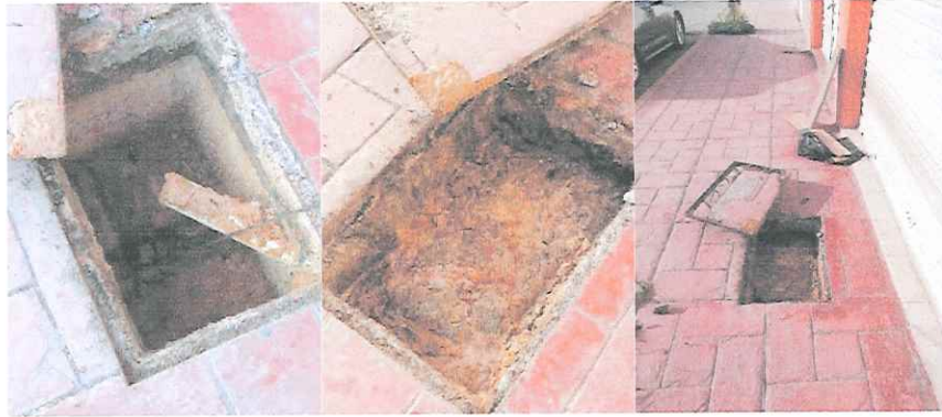
Desazolve de drenaje en contrato 1261 calle hidalgo en el mes de julio
