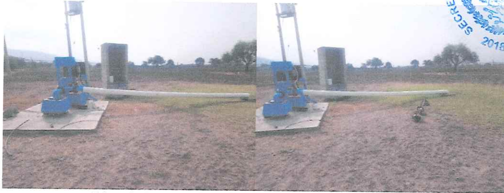
Limpeza y se pintó instalaciones de pozo #3
