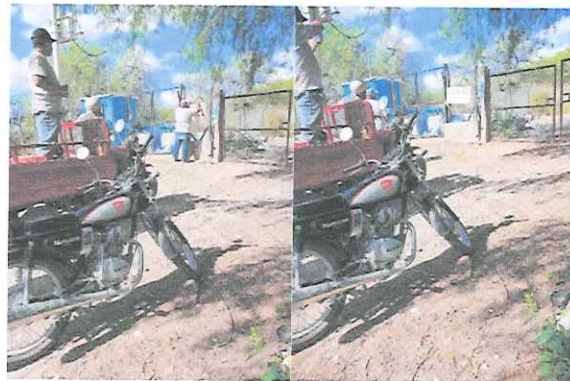
Instalación de letrero en pozo #2.
