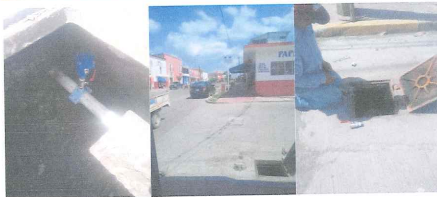
Instalación de válvula 1" en calle Martínez de la vega en pasadita
