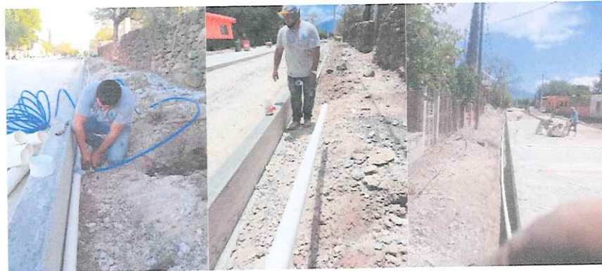
Rehabilitación de calle allende
