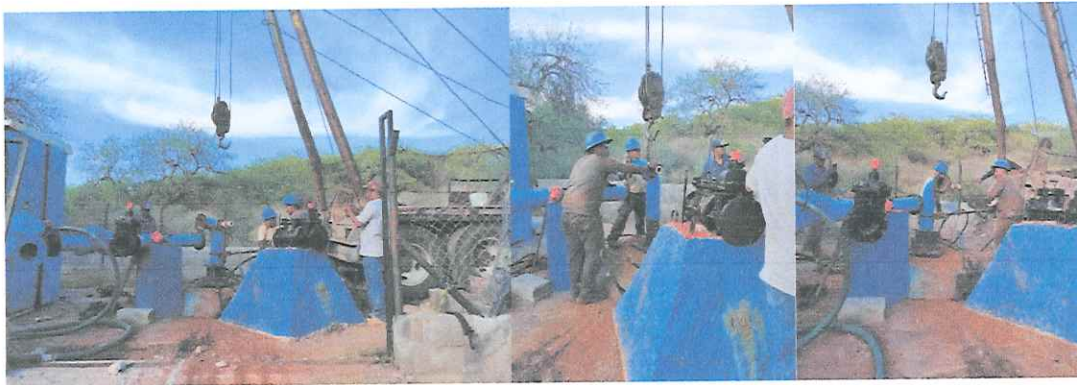
Rehabilitación de bomba de pozo #2
