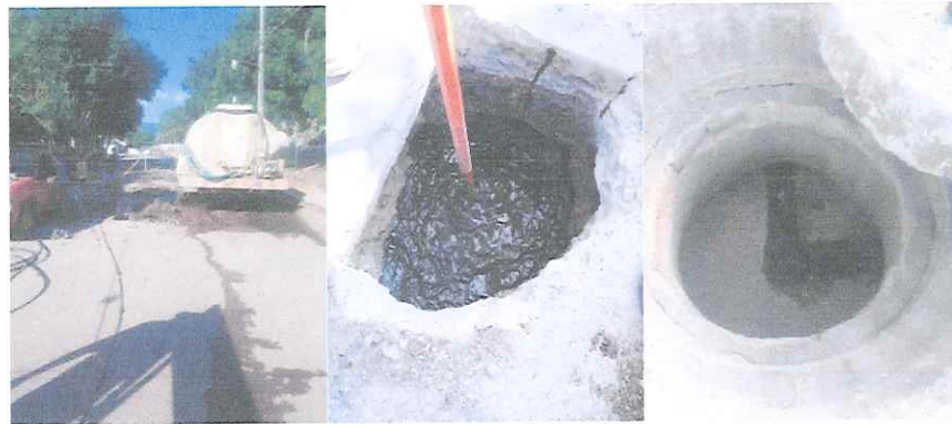
Desazolve de drenaje en calle Martínez de la vega en el mes de octubre.
