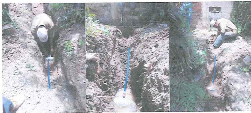
Cambio de material en Calle general Ángeles.
