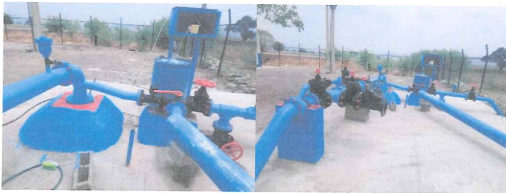
Limpeza y se pintó instalaciones de pozo #1.
