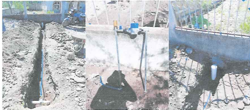
Instalación de contrato nuevo 3483 en calle coronel Antonio en fraccionamiento las viborillas en el mes de octubre,
