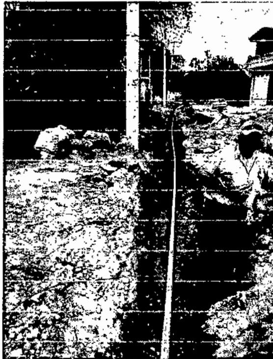
*Ilustración 32. COLOCACION DE TUBERIA PVC RD26 2"*
