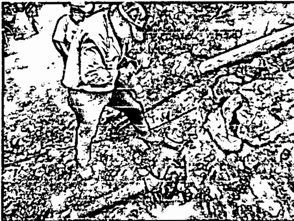
Ilustración 8. REPARACION DE TUBERIA GALVANIZADA 4"
