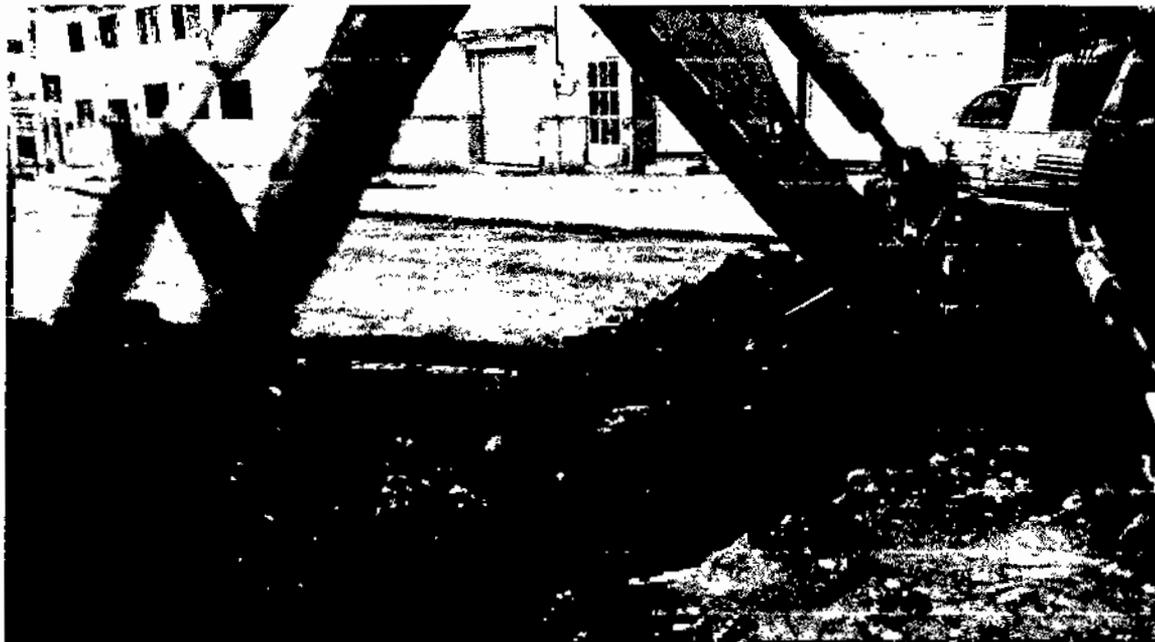
*Ilustración 35. CANCELACION DE TUBERIA OBSOLETA DE ASBESTO-CEMENTO EXISTENTE*
